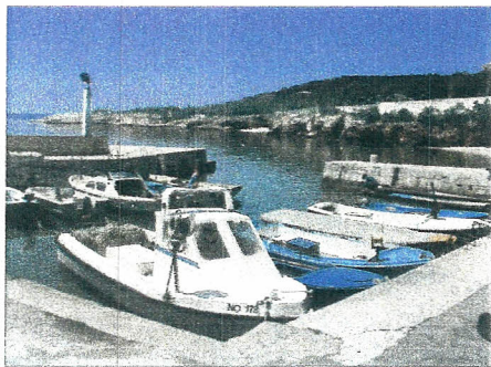
Luka Povile – sanacija obalnih zidova
