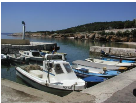
Luka Povile – sanacija obalnih zidova
