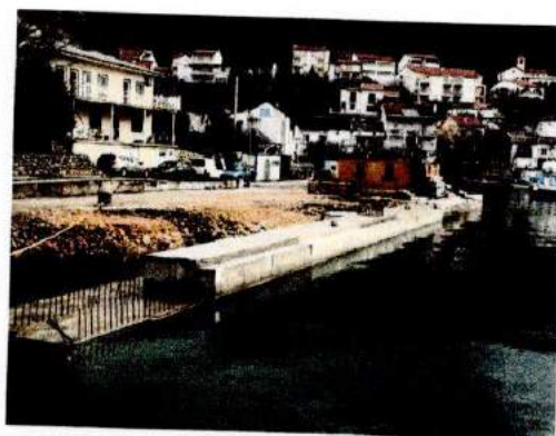
Početak gradnje sekundarnog lukobrana i produljenje operat. obale
