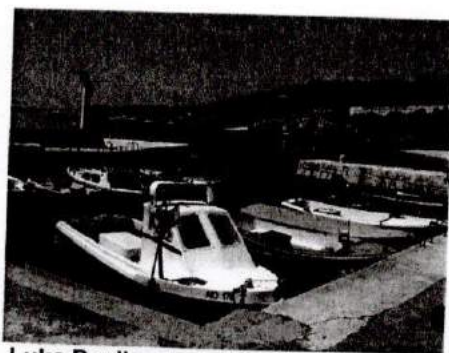
Luka Povile – sanacija obalnih zidova
