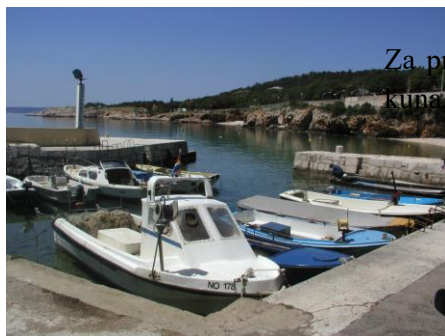
Luka Povile – sanacija obalnih zidova
