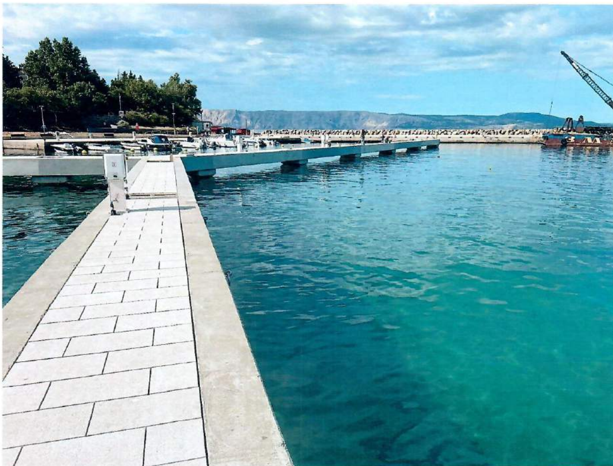
Izgradnja gatova u luci Klenovica – II. faza u 2022.g.
